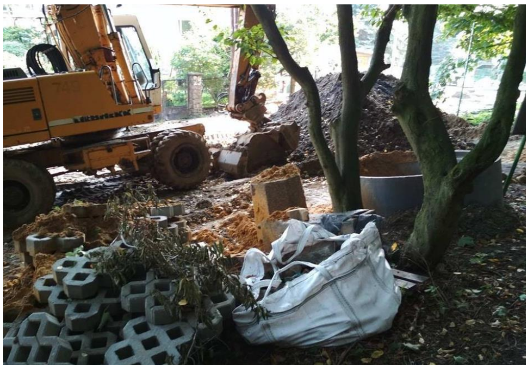
Rys. 15. Przykład zakazanego składowania materiałów w obrębie SOD.
