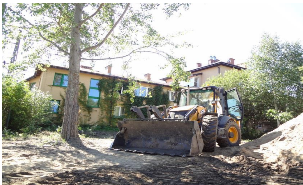
Rys. 14. Przykład zakazanego poruszania się ciężkiego sprzętu w obrębie SOD.
