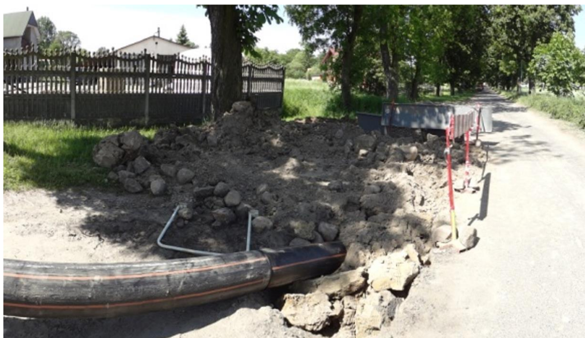
Rys. 19. Przykład montażu instalacji technologią bezwykopową.
