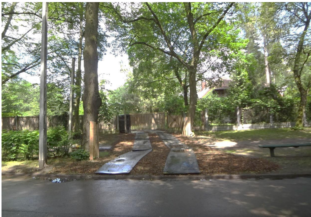
Rys.26. Droga technologiczna wykonana z płyt gumowych ułożonych na warstwie kory.
