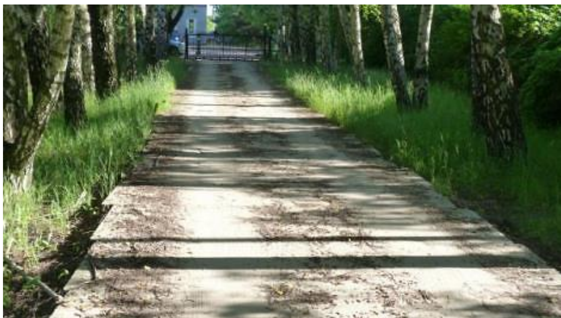
Rys. 25. Droga technologiczna wykonana z płyt betonowych ułożonych na warstwie żwiru.
