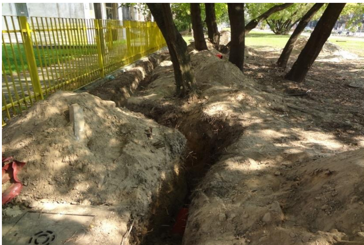
Rys. 18. Przykład otwartych wykopów uszkadzających korzenie drzewa.
